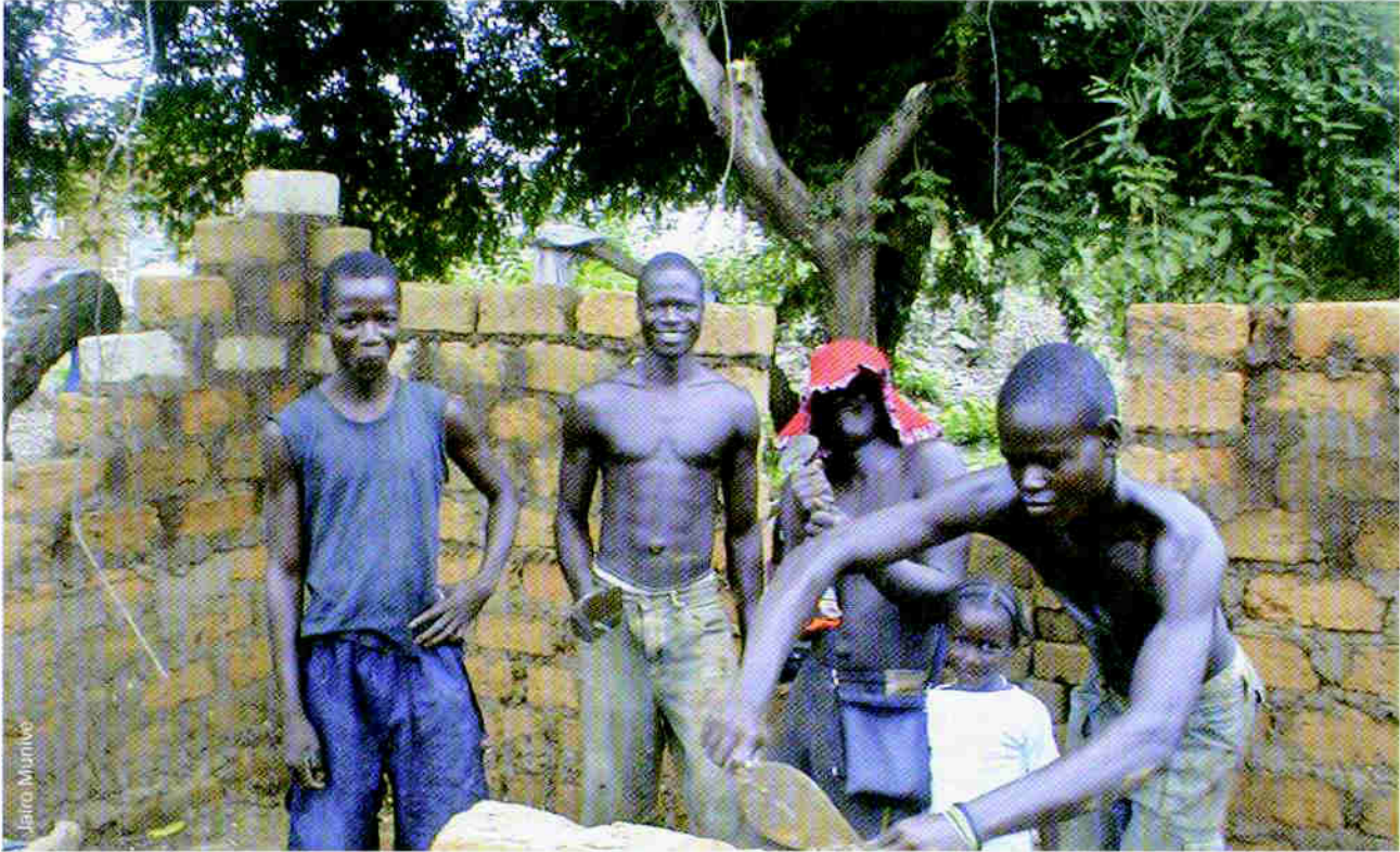
Unos excombatientes y sus familiares construyen una casa en tierras ocupadas ilegalmente en Ganta central.
